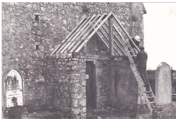
Restauration du porche par le CRDMA en 1981
