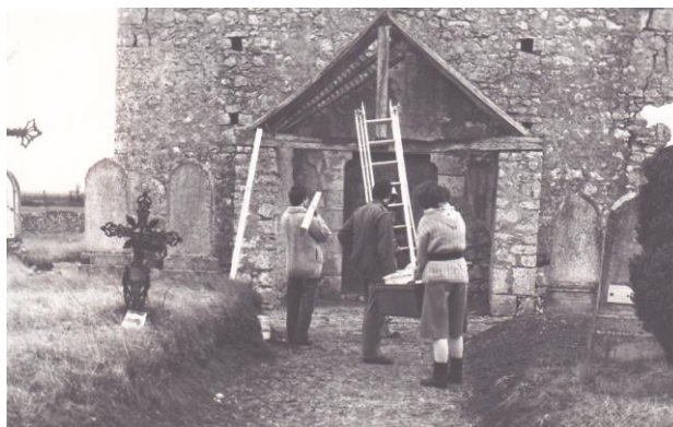
Restauration du porche par le CRDMA en 1981
