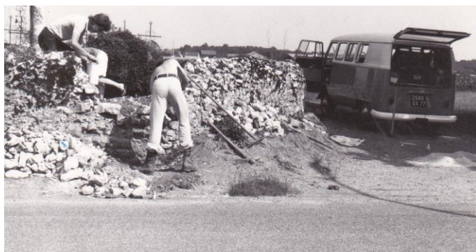
Restauration du mur du cimetière par le CRDMA en 1970
