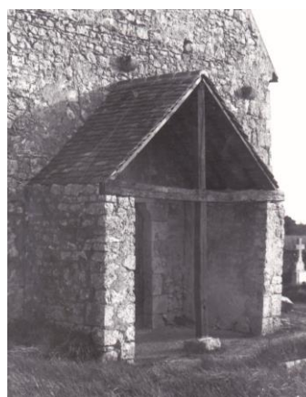
Phase terminale de la restauration du porche Il reste les protections des murs latéraux à mettre en place
