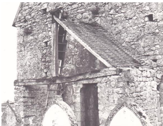
Restauration du porche par le CRDMA en 1981
